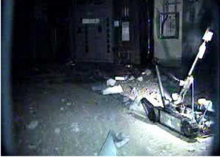
la centrale SIPA
